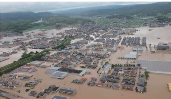
平成30年7月豪雨における岡山県倉敷市真備町の被害状況 (東京消防庁提供)
